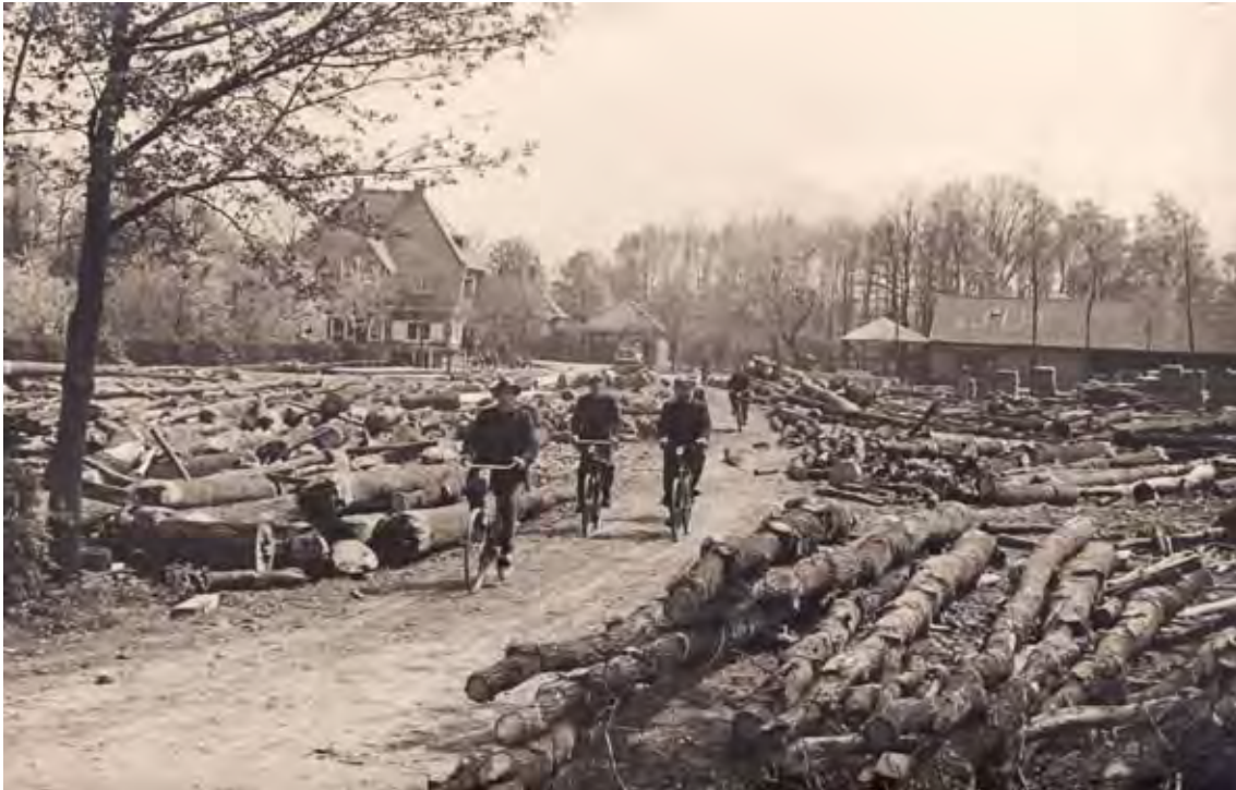
8.11 Winterswijk kent een lange traditie met 'Streekeigen Hout'. Hier 'd'n holtplas' van 'Houthandel en -zagerij J.W. Nijenhuis en Zoon' aan de Kottenseweg. Dit was een van de tenminste zes zagerijen die er halverwege de 20e eeuw waren. (foto: collectie Willem Wilterdink†).
